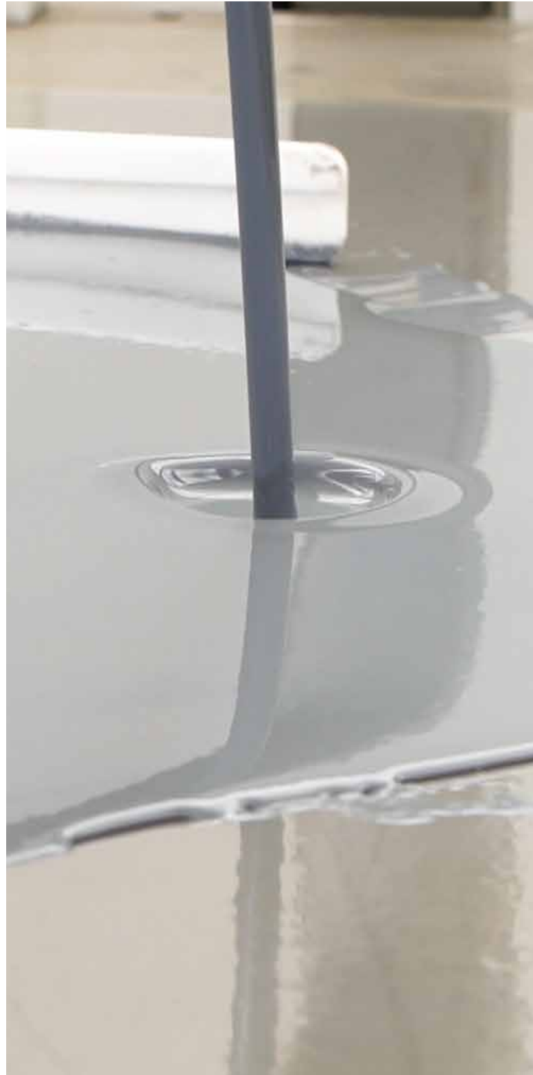
1. Aplicación de la resina y aspersión de la fibra sobre la capa uv que formara una de las caras de la cubierta.
